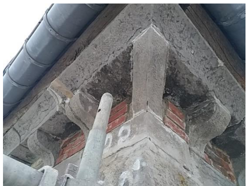
Remise en place de la corniche d'angle du clocher qui avait bougé.
