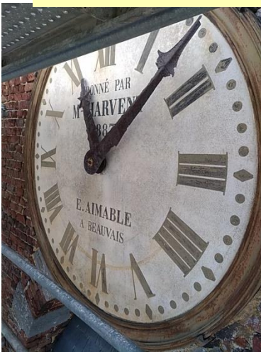
L'horloge monumentale a été nettoyée et repeinte par Jean-Charles Rollet et Marc Boutet, de nouvelles aiguilles et quatre nouvelles minuteries ont été installées.
