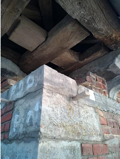
Remise en place de la corniche d'angle du clocher qui avait bougé.
