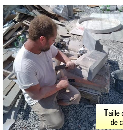
Sur la face nord, remplacement de pierres de corniche brisées.
