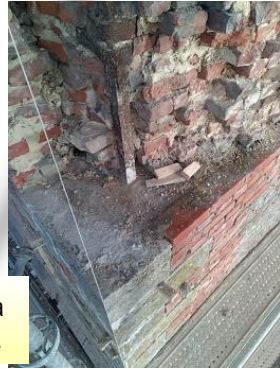
Dépose et repose d'une partie de la chaîne d'angle de droite du clocher.
