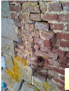
Dépose et repose d'une partie de la chaîne d'angle de droite du clocher.
