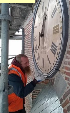
L'horloge monumentale a été nettoyée et repeinte par Jean-Charles Rollet et Marc Boutet, de nouvelles aiguilles et quatre nouvelles minuteries ont été installées.
